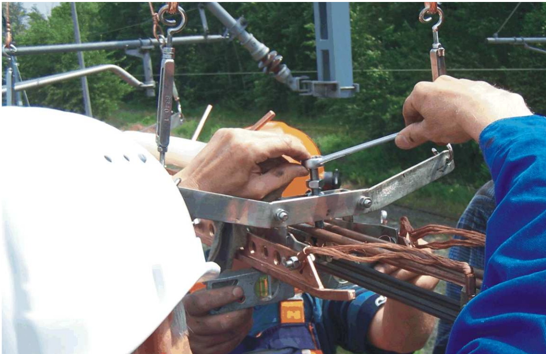
Fot. nr 2 Przedstawia regulację poziomowania korpusu izolatora IS 03.
