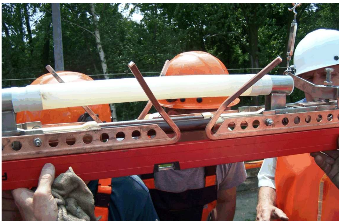
Fot. nr 3 Przedstawia pomiar właściwego ułożenia przewodnic w poziomie.
