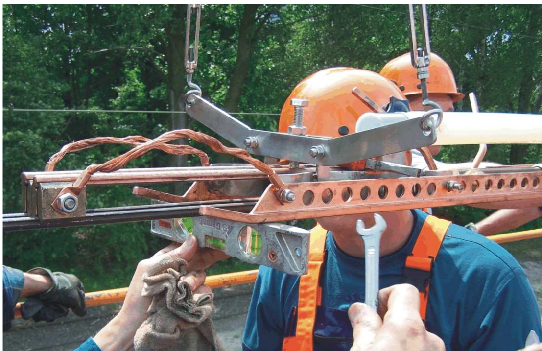
Fot. nr 4 Przedstawia pomiar właściwego ułożenia przewodnic względem siebie.
