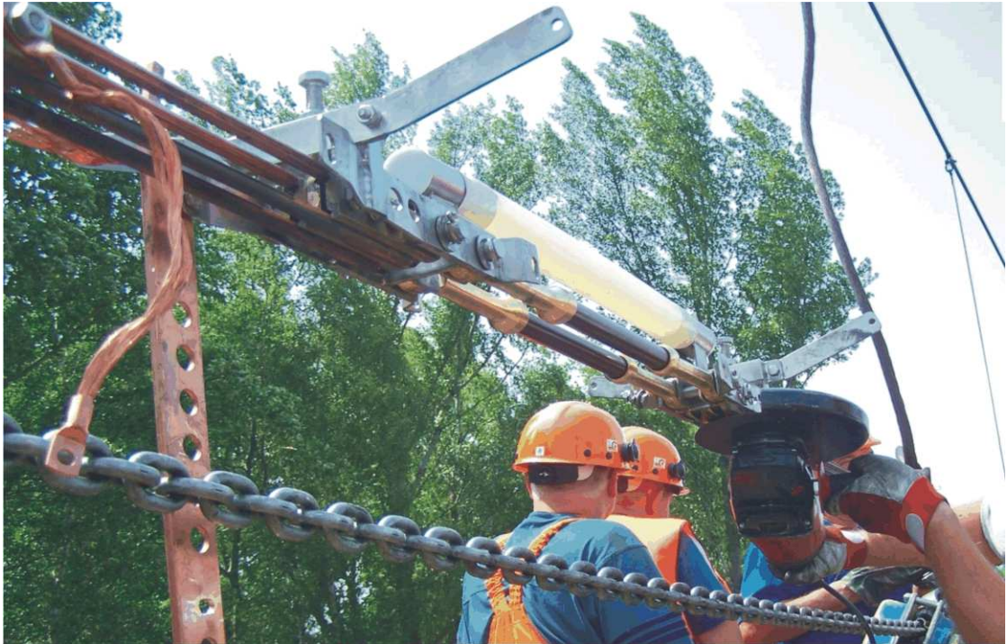
Fot. nr 1 Wygładzenie przewodów jezdnych po wmontowaniu w izolator sekcyjny.
